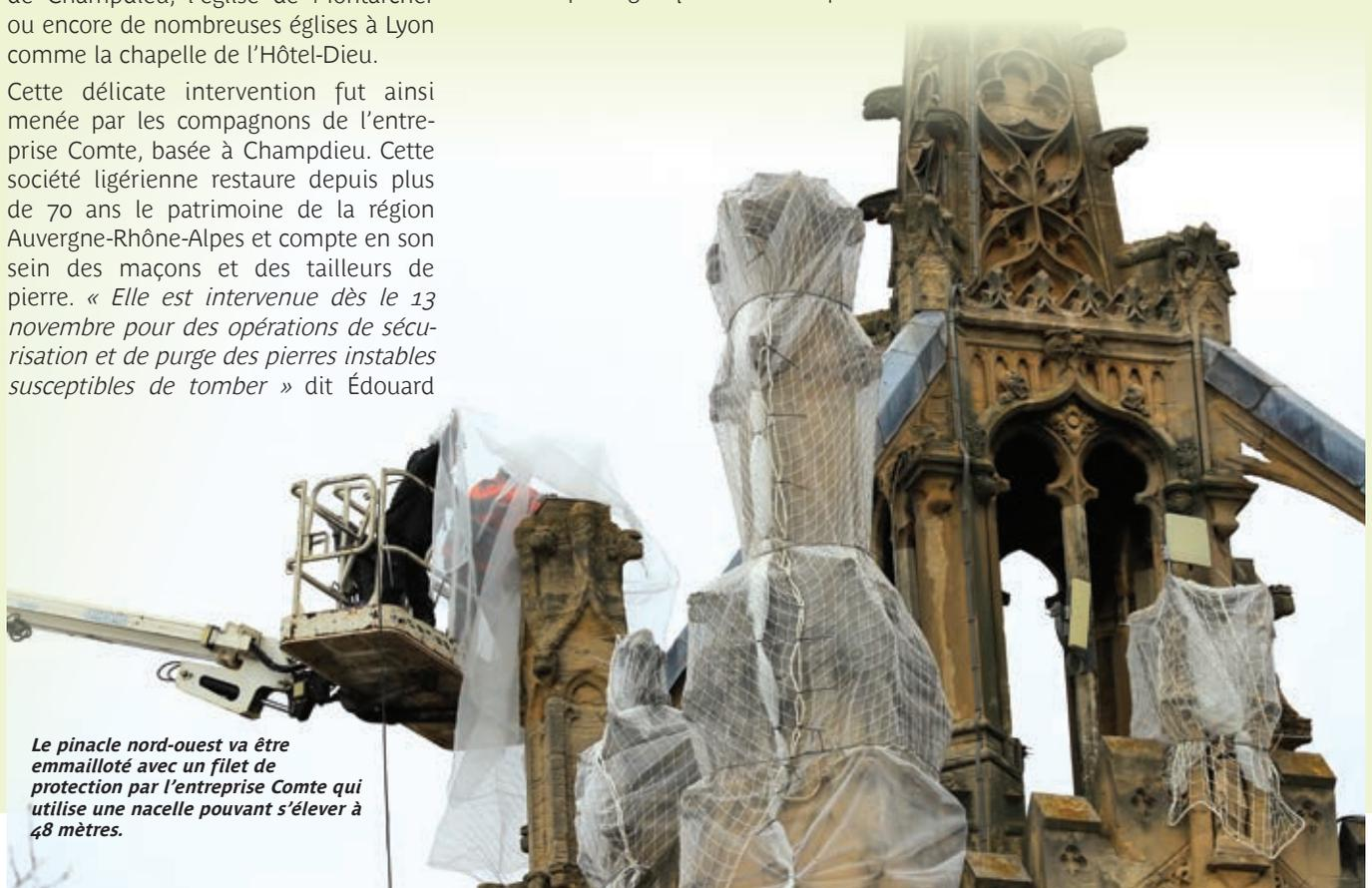
Le pinacle nord-ouest va être emmaillotté avec un filet de protection par l'entreprise Comte qui utilise une nacelle pouvant s'élever à 48 mètres.
